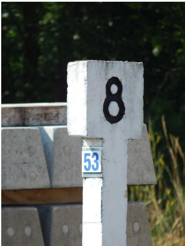
Borne hectométrique : le km (53) est rappelé en dessous de l'hectomètre (8) et la hauteur de la borne la rend visible de loin... et peu sensible à une végétation dense au sol : un système efficace pour permettre aux agents de conduite de se repérer.
